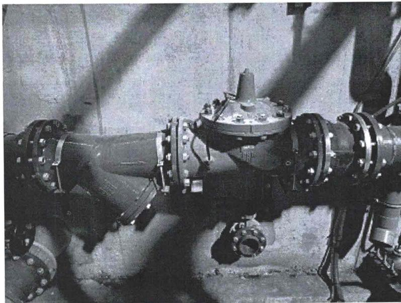
**76. Temos nun hospital un alxibe de auga para almacenamento e suministro de auga para o Centro. Na instalación de entrada de auga ó alxibe, atópase o elemento que se amosa na figura que se achega. De que elemento se trata?**
